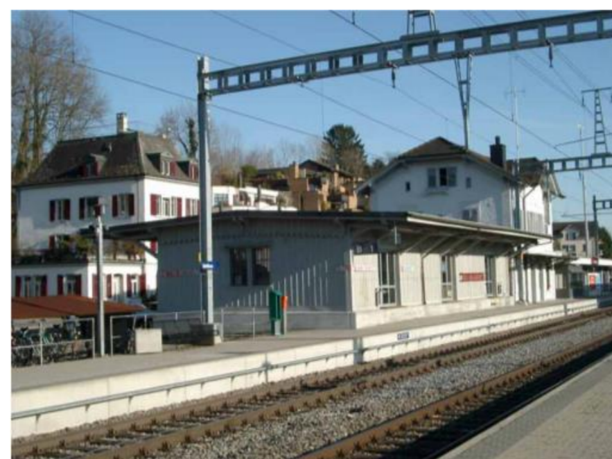
Güterschuppen Zustand heute
