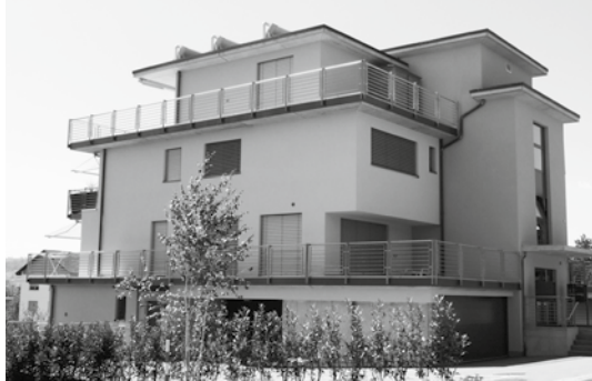
Abdichtungsarbeiten Neubau MFH Männedorf
