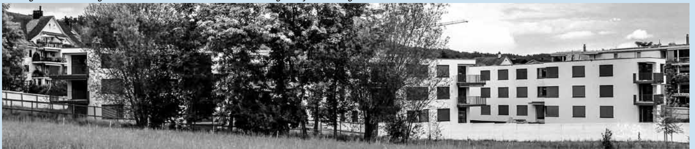
Planung und Realisierung: innert anderthalb Jahren sind in der Scheug an idyllischer Lage drei schlichte Wohnblöcke entstanden.
